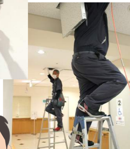
ケーブル増設作業
