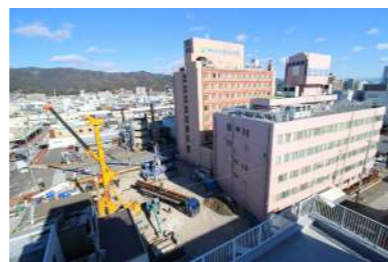
2022年1月19日現在の建設現場（南館8階より撮影） 重機のある場所に現在の第5病棟を建設中
