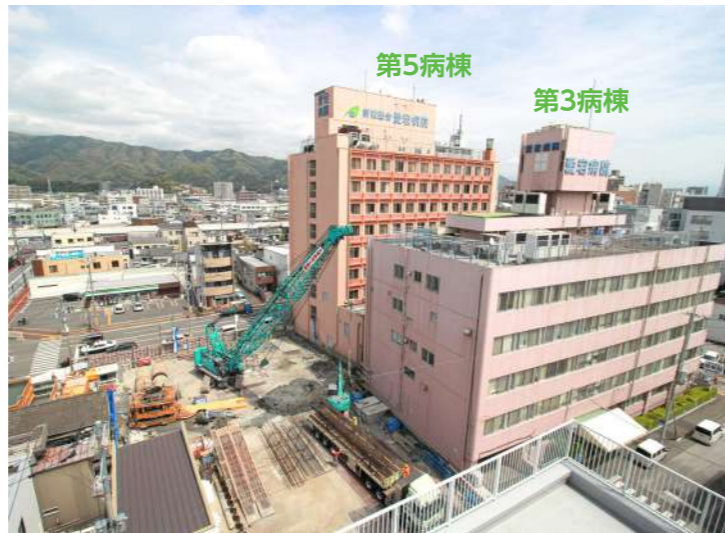
2022年4月12日現在の建設現場(南館8階より撮影)
