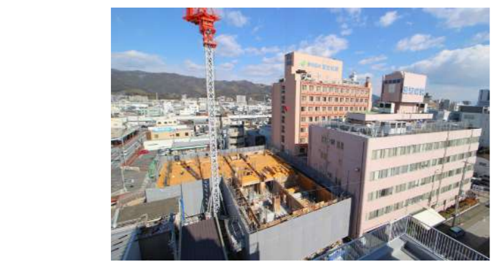
2023年1月30日現在の建設現場(南館8階より撮影)
