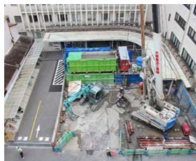
上空通路設置工事 2023年7月14日北館6階より撮影
