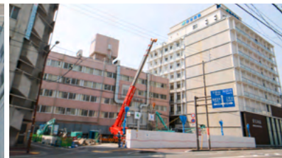
病院北側より(2025年4月17日撮影)
